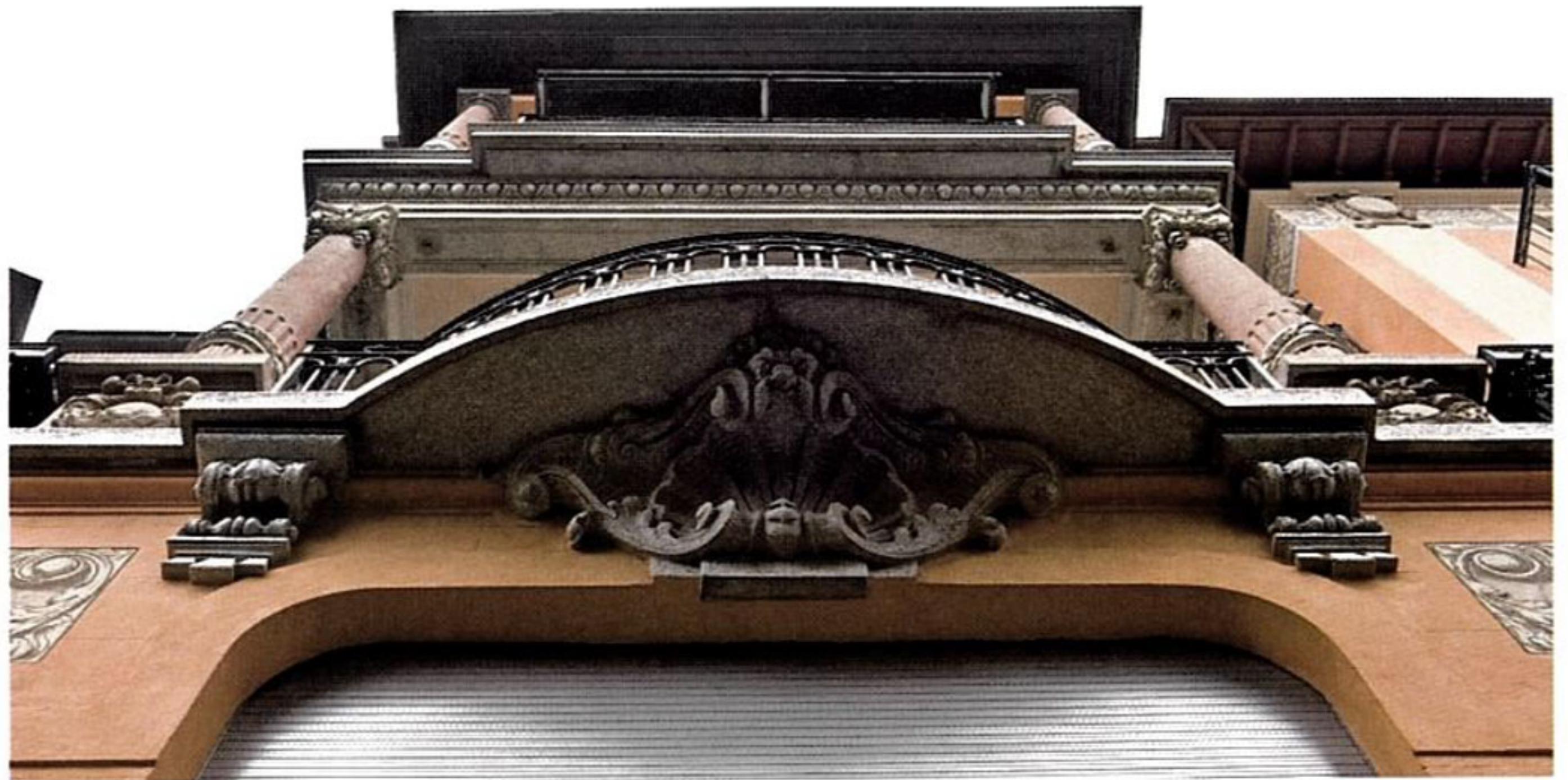
In alto: facciata ovest, particolari del bow-window; in basso: vista della terrazza a sud (foto: Renato Quadroni).
