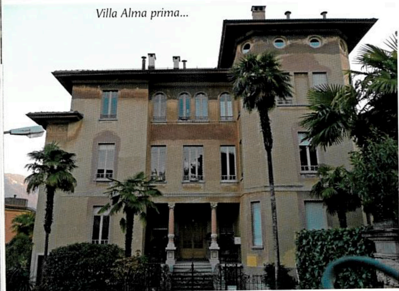
...e dopo il restauro
